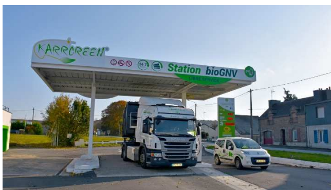
Station GNV de Locminé (56) - Source : www.gaz-mobilite.fr
